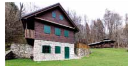
NP Risnjak → Rodna kuća rijeke Kupe
